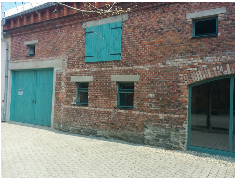
Obr. 2 – Umístění pamětní desky na levé straně průjezdu –vchodu do Muzea
